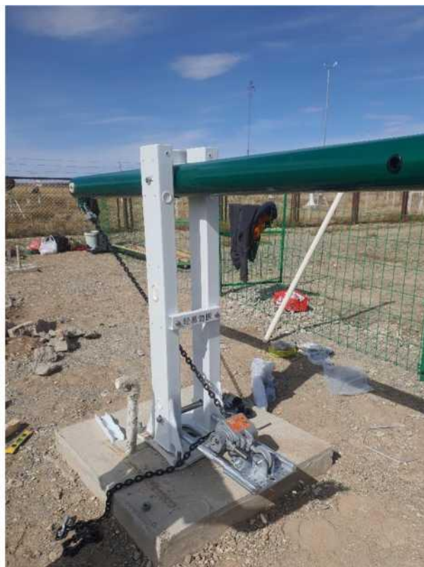
Зураг: Тоног төхөөрөмжүүдийг зөөж байрлуулан автомат станцын мэдрүүрүүдийн суурь цутгаж бэлтгэсэн байдал
